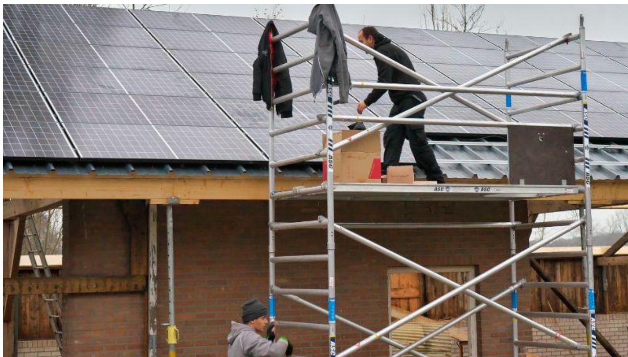
De eerste 96 zonnepanelen worden op het dak van de kapschuur geplaatst
